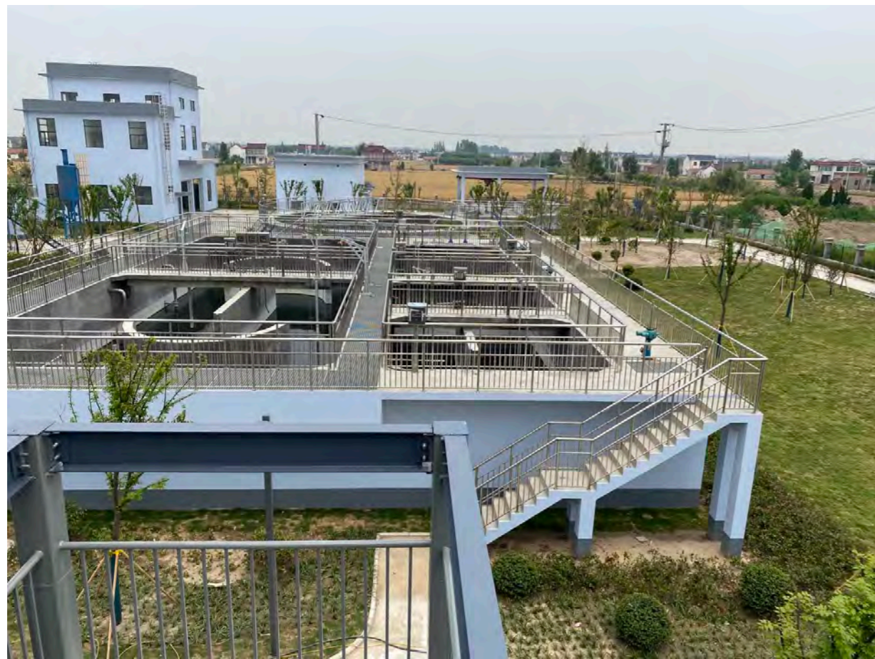
污水处理厂项目 Sewage Treatment Plant Project
