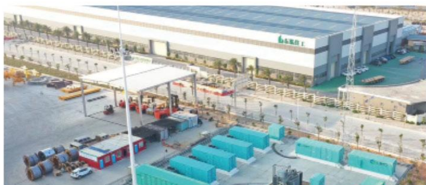
汕头风光储智慧能源 1MW/1MWh 储能项目
